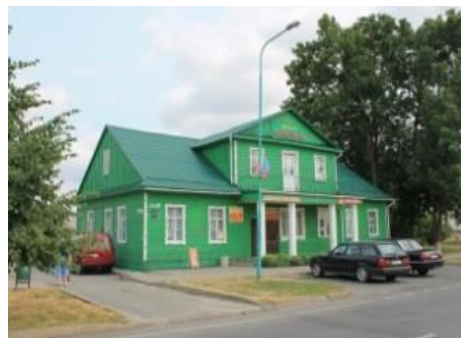
Рис. 2 – Здание бывшей аптеки (1828 г. постройки), г. Пружаны – Фото автора
